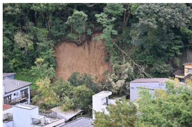
佐倉市京成佐倉駅近くのがけ崩れ(2026年9月28日) 報道はされないが、千葉豪雨や台風25号による小規模ながけ崩れは各所で見られる (撮影: 田中正彦)
