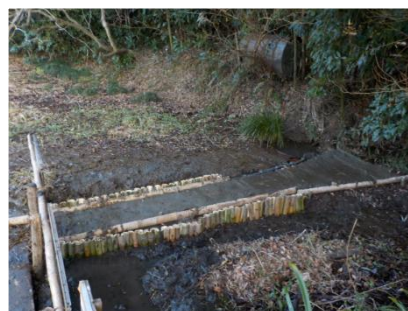
「盛土し完成した状況」
