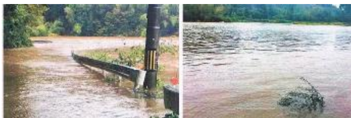
図3. 村田川沿いでは、従来は氾濫を免れていた場所でも氾濫が発生している
